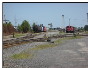
Voie ferrée du CP (photo GGBB)
