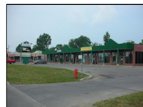
chemin de la Rivière-Cachée (photo GGBB)
