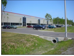
rue Marcel-Lacasse (photo GGBB)
