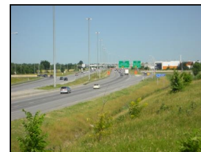
Autoroute des Laurentides (A-15) (photo GGBB)
