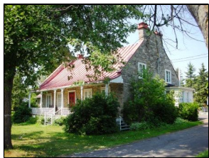
331, chemin de la Grande-Côte (photo GGBB)
