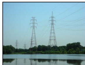
Ligne hydro-électrique (photo GGBB)
