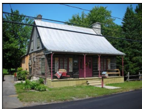
541, chemin de la Grande-Côte (photo GGBB)
