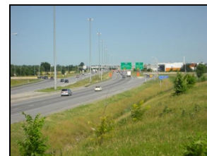
Autoroute des Laurentides (A-15) (photo GGBB)
