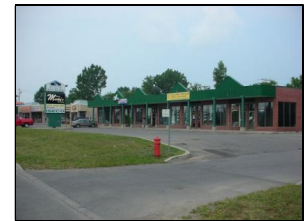
chemin de la Rivière-Cachée (photo GGBB)
