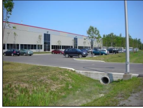
rue Marcel-Lacasse (photo GGBB)
