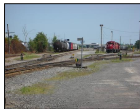
Voie ferrée du CP (photo GGBB)
