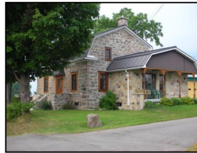
3510, chemin de la Rivière-Cachée (photo GGBB)
